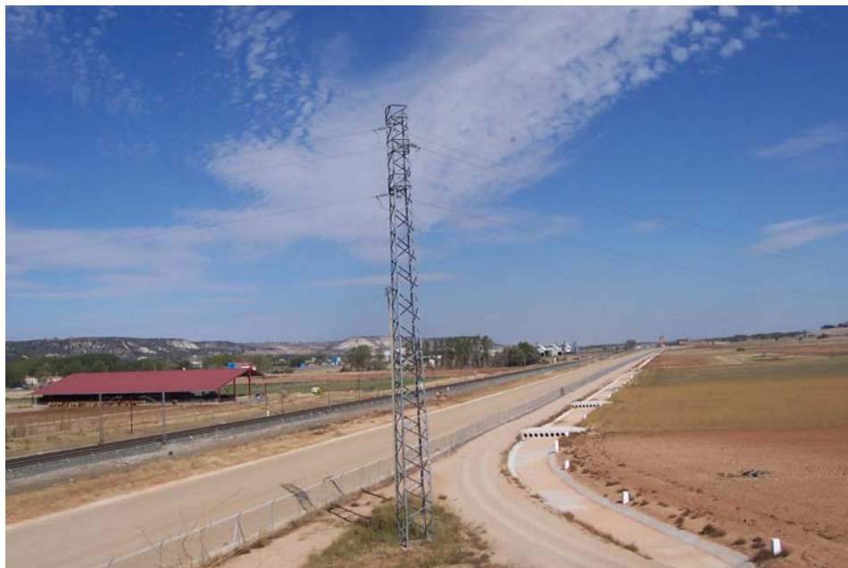
Imagen- Vía Férrea Madrid-Irún, por su paso por el término de Herrera de Valdecañas.
